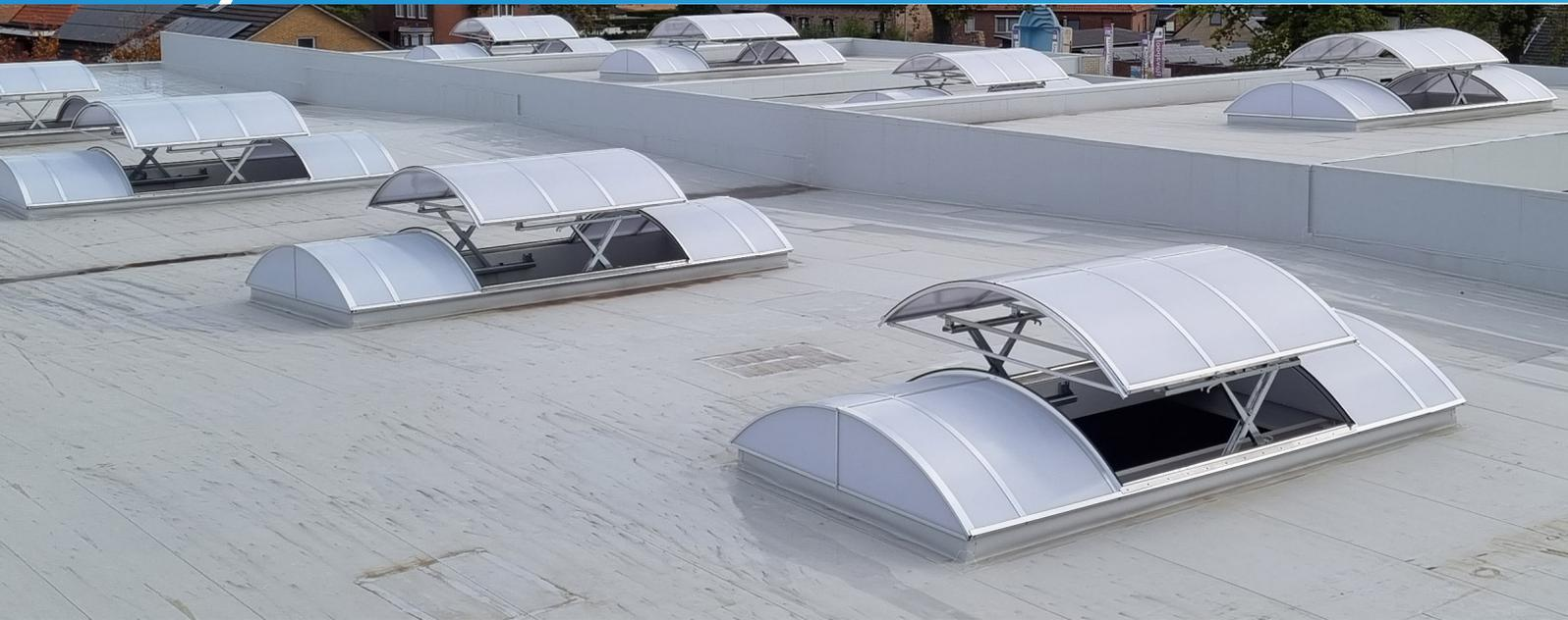
Der Beschlag dient zum Öffnen und Schließen von Geräten für den natürlichen Rauch- und Wärmeabzug wie Dachkuppeln oder Lichtbandklappen. Der Scherenbeschlag ist in elektrischer Ausführung mit Elektroantrieben und in pneumatischer Ausführung mit Pneumatikzylindern erhältlich.
